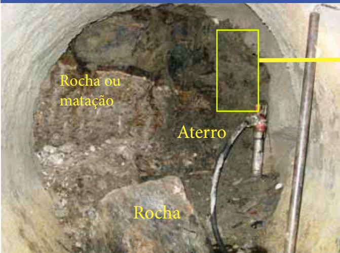
Escavação A 11m da boca
