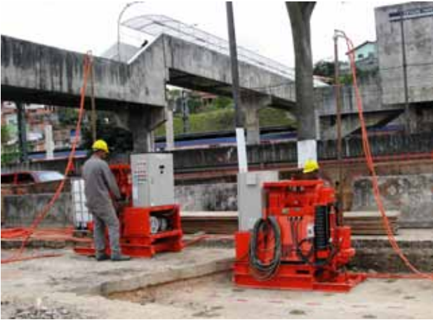
Execução de injeções ECORYON
