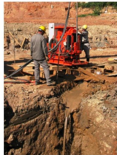
Foto 5: aspecto do tratamento superficial com refluxo
