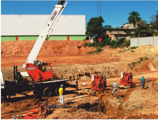
Foto 1: vista geral da Obra
